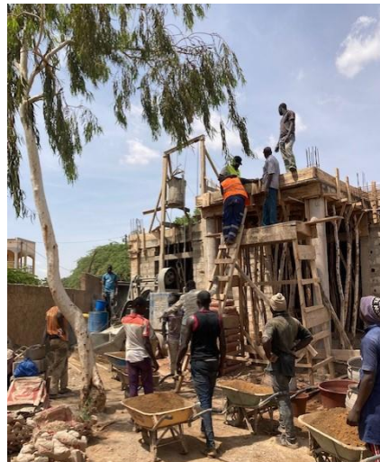
Beton storten kerk
